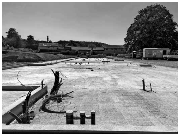
Schulhaus Vorstadt: Bodenplatte
