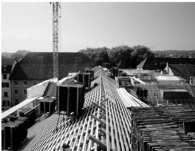
Schulhaus Kollegium: Dachdeckerarbeiten
