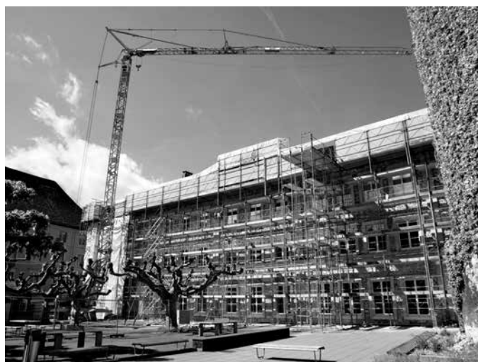
Schulhaus Kollegium: Fassadengerüst
