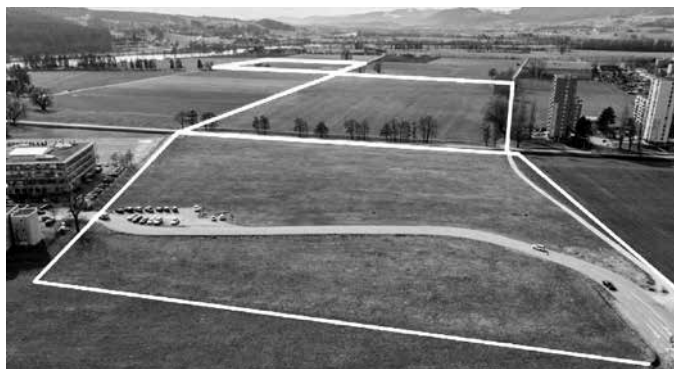
Sanierung Stadtmist Solothurn; vorne «Deponie Unterhof», Mitte «Deponie Spitefeld» und hinten «Deponie Oberer Einschlag»; Foto Amt für Verkehr und Tiefbau, Kanton Solothurn
