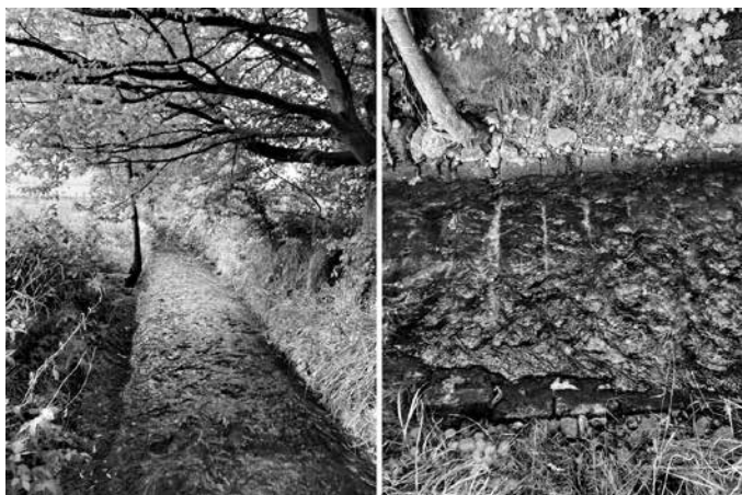
Wildbach, massiv verbaute Bachsohle und Böschungsfuss; Foto Kissling + Zbinden AG
