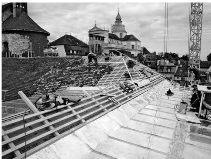
Schulhaus Kollegium: Dachdeckerarbeiten
