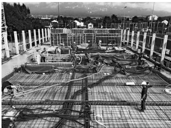
Schulhaus Brühl: Baustelle
