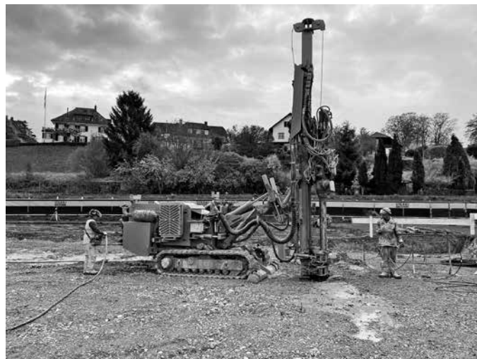
Schulhaus Vorstadt: Pfählung
