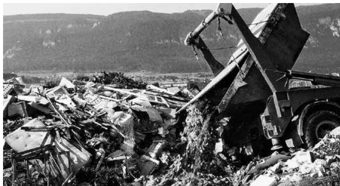
Sanierung Stadtmist Solothurn; Foto Amt für Verkehr und Tiefbau, Kanton Solothurn
