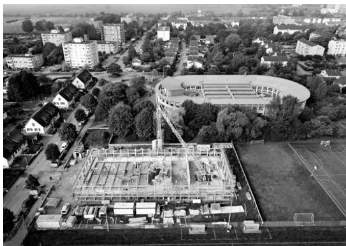
Schulhaus Brühl: Baustelle
