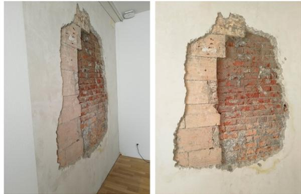
Freigelegtes Mauerwerk zur Austrocknung
